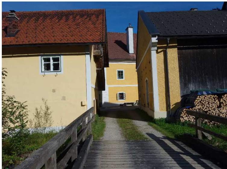
Blick zum Hof von der Brücke über den Bach
