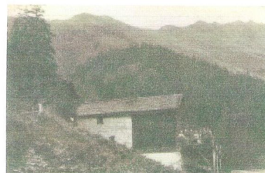
Guschahütte nach dem Ausbau
