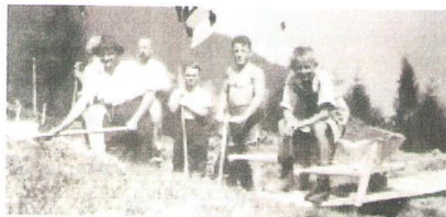
Spatenstich auf der Jägeri
